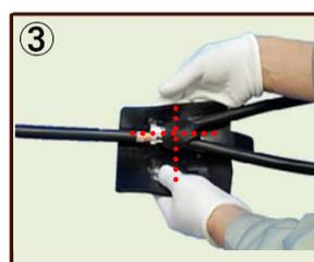
③ パテシートの剥離紙をはがし、位置決め目印に接続部を合わせて巻きつけます。
