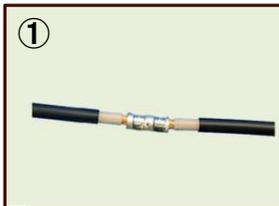
① ケーブル処理を施し、圧着接続します。
