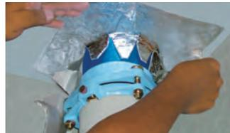
②切れ目からパイプに差し込み、離型紙を全部はがしとって天井面に圧着する。
