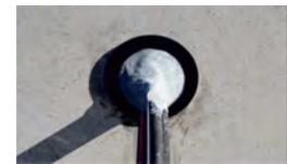
8 CVTケーブルの場合、仕上げに撚り中央部を指先で念入りに充填し、充填作業完了。
