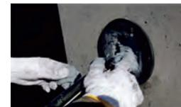
7 オニギリ状のとめ太郎を入れ終わったら、入念に奥側⇒手前、下側⇒上側へと充填。特に管路凹部は指先で細かく充填する事で止水効果が向上します。
