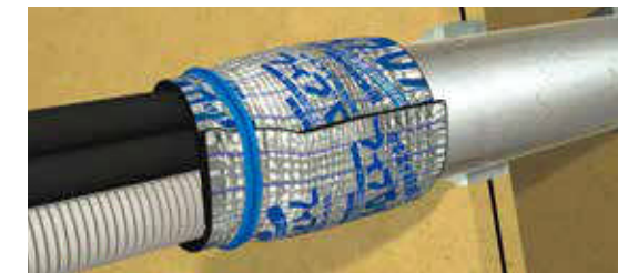
●施工例(PF管の貫通)
