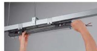
入力用、送り用の端子台をそれぞれ設けているため、仮吊り状態で簡単に配線線の接続作業が可能です。
