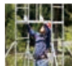
上階用布枠により、先行して 手すりが取付けられ、安全 帯をかけながら、安全に 組立てが可能です。
