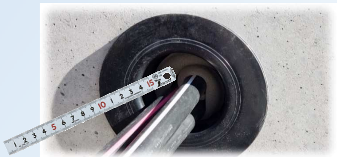
③とめ太郎充填厚目安を参考に計測、位置確定。
