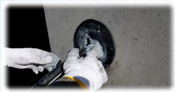
⑦オニギリ状のとめ太郎を入れ終わったら、入念に奥側⇒手前、下側⇒上側へと充填。特に管路凹部は指先で細かく充填する事で止水効果が向上します
